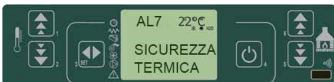
fig. 42 painel de comandos - alarme por termóstato geral
