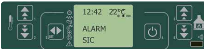
fig. 38 painel de comandos - alarme por termóstato geral
