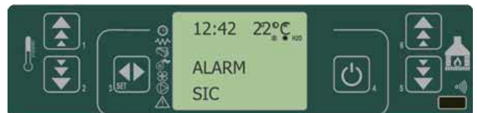
fig. 38 tableau de commande - alarme du thermostat général
