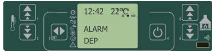
fig. 37 tableau de commande - alarme du pressostat de sécurité de la vis sans fin
