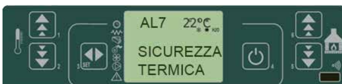
fig. 42 tableau de commande - alarme du thermostat général
