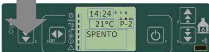
fig. 33 painel de comandos - desligamento
