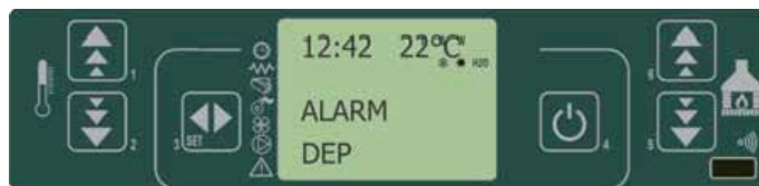
fig. 37 painel de comandos - alarme por pressóstato de segurança da rosca sem-fim
